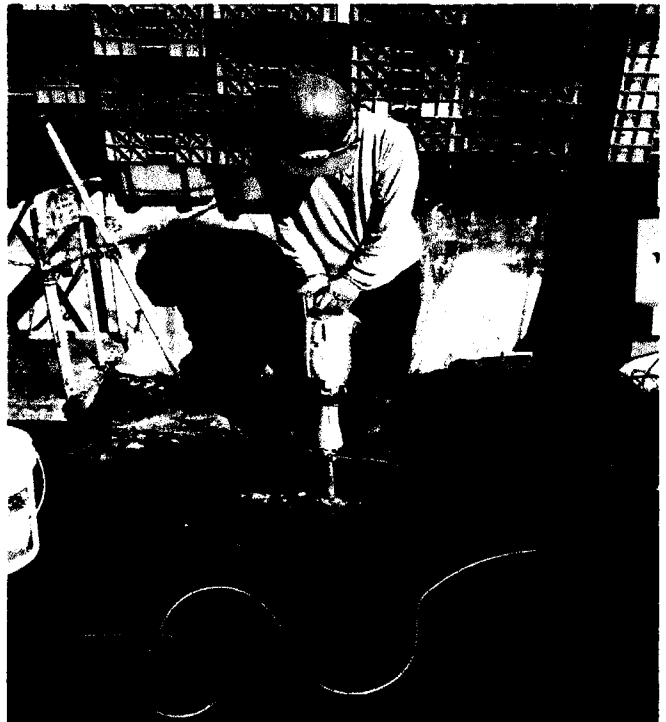
ROTURA DE PAVIMENTO PARA CAJUELAS USO DE EPPS
